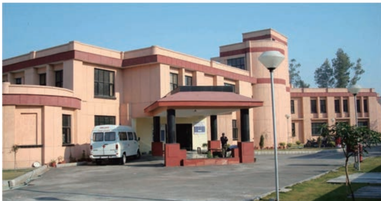
図14：インド、ウッタル・プラデーシュ州、ノイダに所在するホメオパシー中央研究所。臨床研究、臨床検証、レメディー・ブルーピング、レメディー標準化研究を実施する50床あるIPD（入院部門）に加え、OPD（外来診療部門）設備を供給している。
